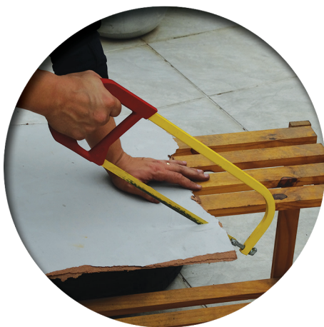
Figura 4: Posicione a tampa cortando-a com o auxílio de um serrote; esta pode ser feita de diversos materiais, como por exemplo, um compensado.
