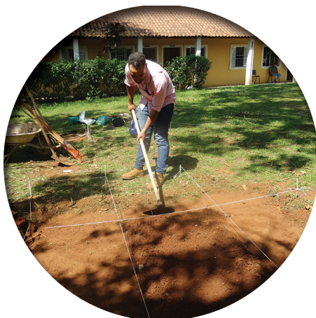
Figura 6: Compactação das bordas do canteiro.
